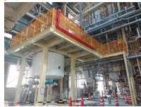
民間のお客様の工場のタンク架台の新設工事をさせていただきました。工場や事業所のお困りごとがありましたら外構工事(舗装工事や水路工事等)も含めて何でもご対応させていただきます。
