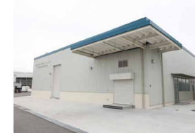
新たに増設したクリーンルームを完備したクリーン棟です。
