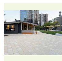
遮熱性舗装材(東遊園地)
