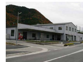
日本のへそに所在する本社工場
