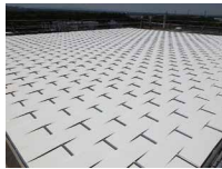
民間のお客様のご要望により、屋根を遮熱シートに取り換える工事をさせていただきました。お客様のニーズに応えるべく品質とスピードを兼ね備えた施工をしております。
